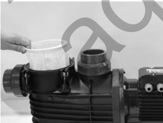
Tägliche Reinigung des Filterkorbes!
