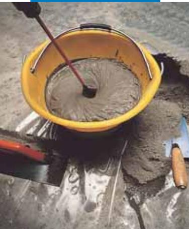
Перемешивание Nivorapid при помощи механического миксера
